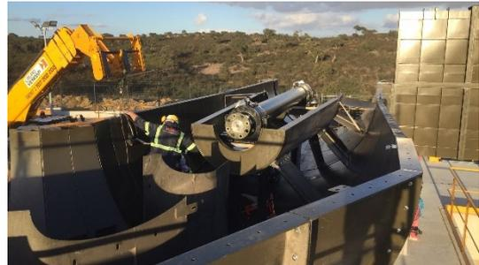
*Fig. 7 – Montagem do veio do ventilador*
